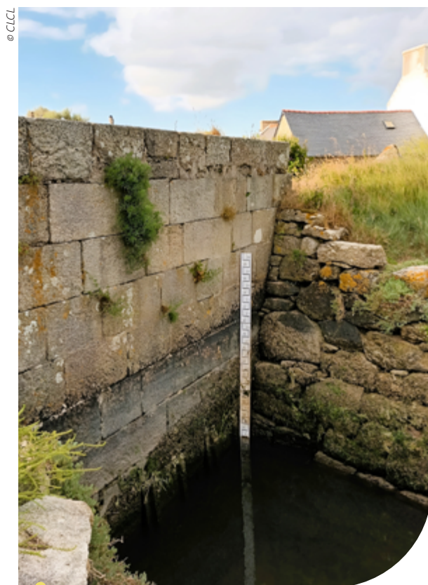
Installation d'une échelle limnimétrique sur la digue du Curnic à Guissény.
