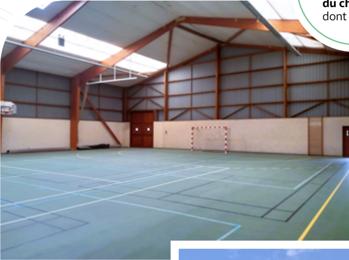
Guissény • Réhabilitation de la salle omnisport Jean Fily
