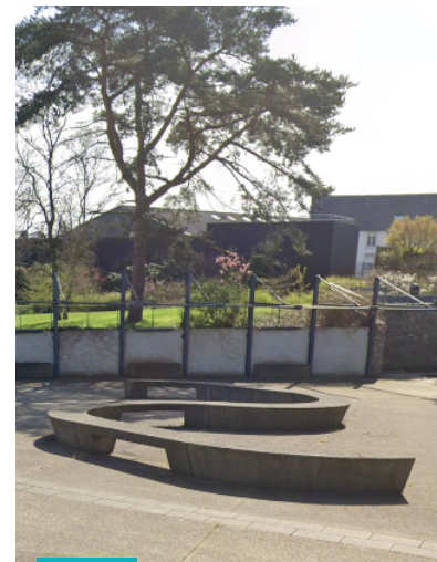
Aménagement d'une esplanade rue de la Libération dans le cadre du projet de cheminement doux de la coulée verte (Parcou-Kerjézéquel) à Lesneven.
