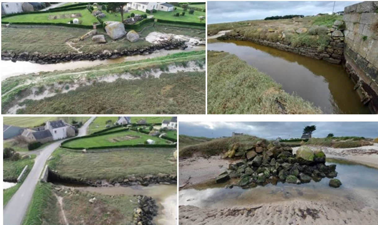
Figure 4. Clichés des clapets et ortho photo localisant l'ouvrage hydraulique
