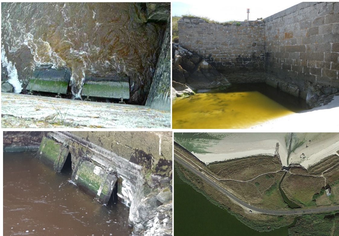
Figure 7. Clichés des clapets et ortho photo localisant l'ouvrage hydraulique
