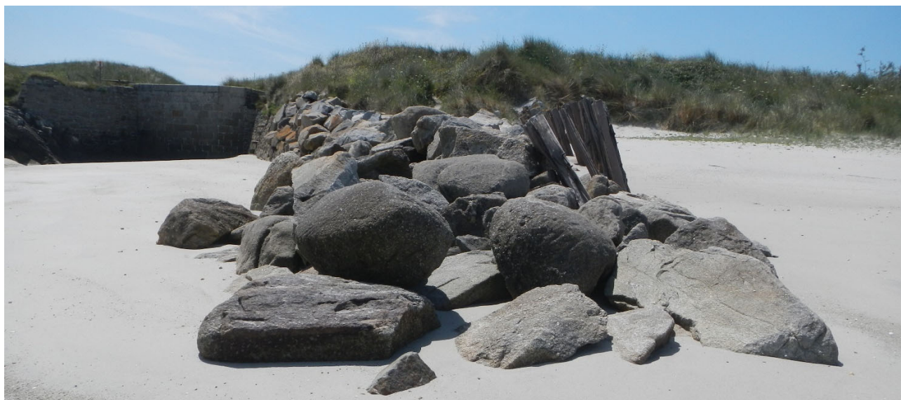
Figure 12: Photographie de l'ouvrage et de ses alentours
