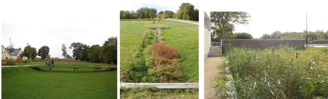
Exemple de bassins paysagés et noues plantées
