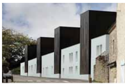
Habitat collectif Saint Nolf, ARCAU architecte
