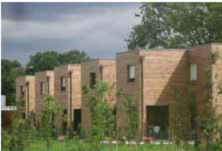
Une forme en L qui permet de ménager un espace d'intimité
