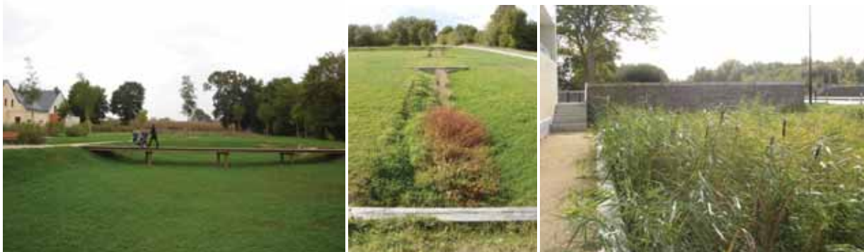
Exemple de bassins paysagés et noues plantées
