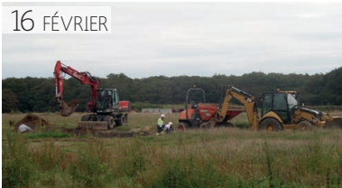
Travaux de viabilisation de la zone du Kerno-Parcou pour la création de 30 lots
