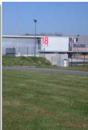
Construction du centre de secours à Kerjézéquel à Lesneven
