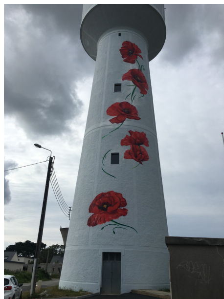
> Réhabilitation de deux châteaux d'eau: Lesneven (ci-contre) - Kerlouan,
