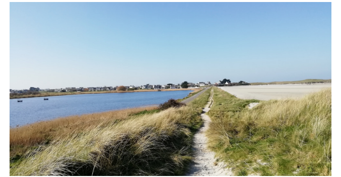
Digue du Curnic
