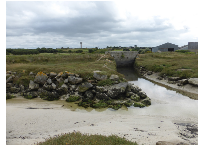
Digue de Kerlouan
