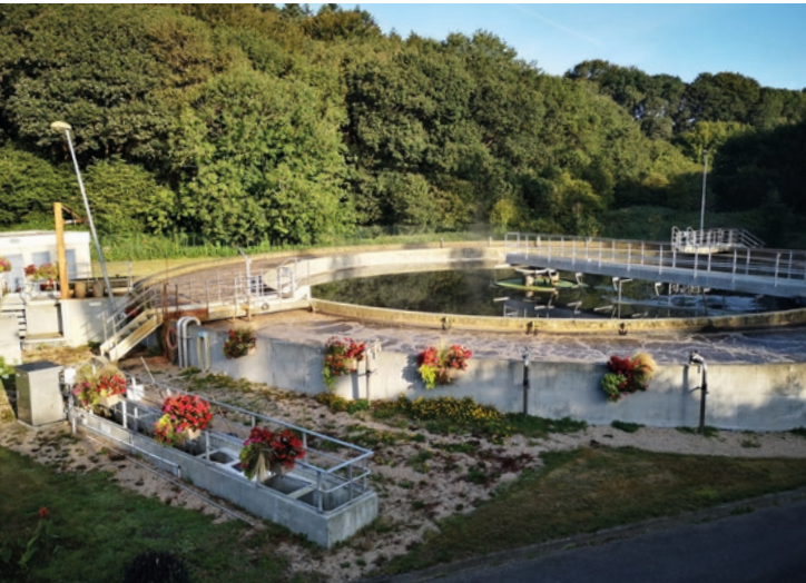
Station d'épuration de Lesneven
